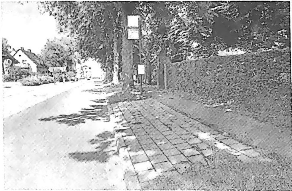
Die Bushaltestelle an der Friedhofstraße. Der Gehweg fällt in Richtung Straße ab und erschwert beispielsweise Rollatornutzern den Einstieg.
